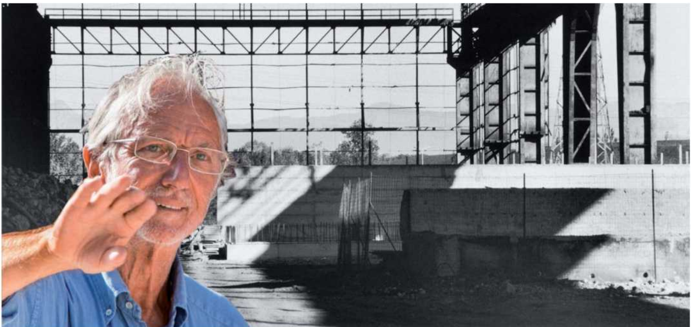
RIQUALIFICARE | Renzo Piano e il cantiere di Sesto San Giovanni (foto G. Berengo Gardin)
